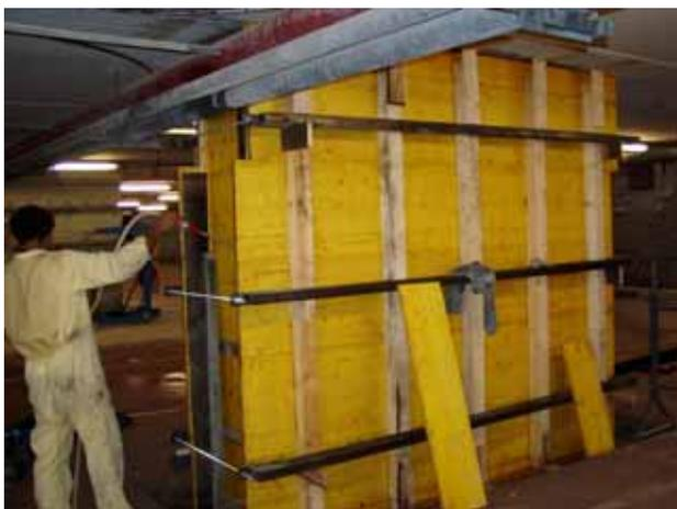
Per spessori > di 5 cm si è consigliabile l'utilizzo del betoncino EMACO FORMULA REODINAMICO B1. Le casseforme debbono essere di materiale di adeguata resistenza, sufficientemente impermeabili, per evitare sottrazioni di acqua all'impasto, saldamente ancorate, contrastate e sigillate per resistere alla pressione esercitata dalla malta ed evitare perdite di materiale.
