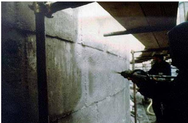
Durante le fasi di interruzione dello spruzzo (in funzione anche della temperatura esterna) è necessario prevedere l'accurata pulizia delle tubazioni e della pompa stessa mediante acqua in pressione e palla di gomma morbida pulisci tubi.
