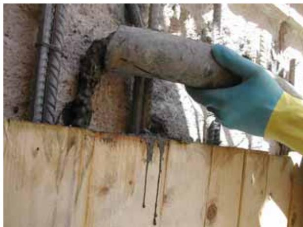
La sua particolare reologia gli consente di autocompattarsi senza necessità di vibrazione e di scorrere anche in strutture fortemente armate e/o a geometria complessa.
