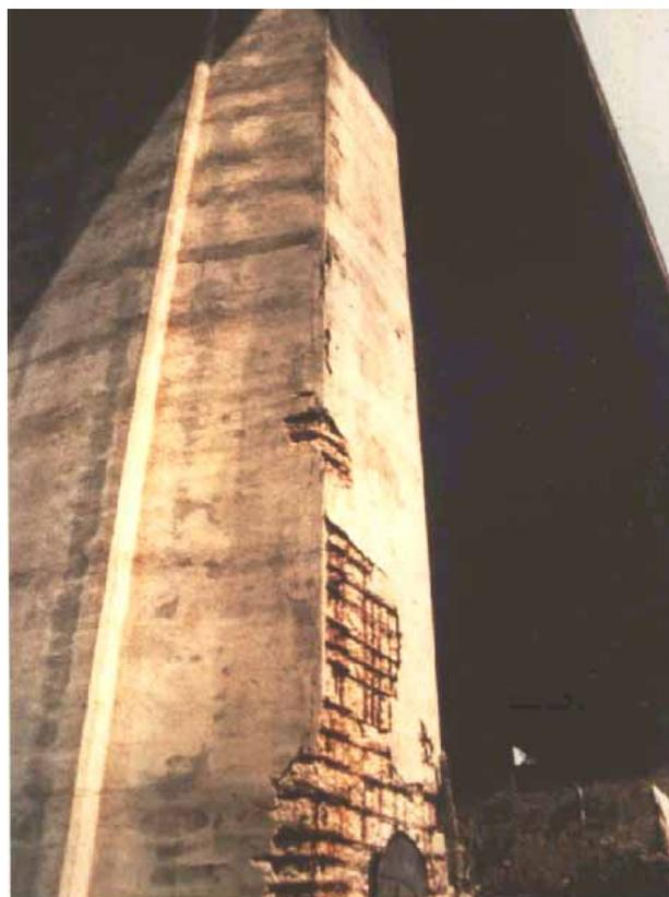
Può essere applicato con macchina spruzzatrice o a cazzuola, su calcestruzzi macroscopicamente irruviditi (asperità di circa 5 mm), in spessori d'intervento compresi tra 1 e 5 cm, senza applicazione di rete elettrosaldata.
