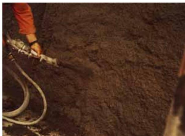
Durante le fasi di interruzione dello spruzzo (in funzione anche della temperatura esterna) è necessario prevedere l'accurata pulizia delle tubazioni e della pompa stessa mediante acqua in pressione e palla di gomma morbida pulisci tubi.
