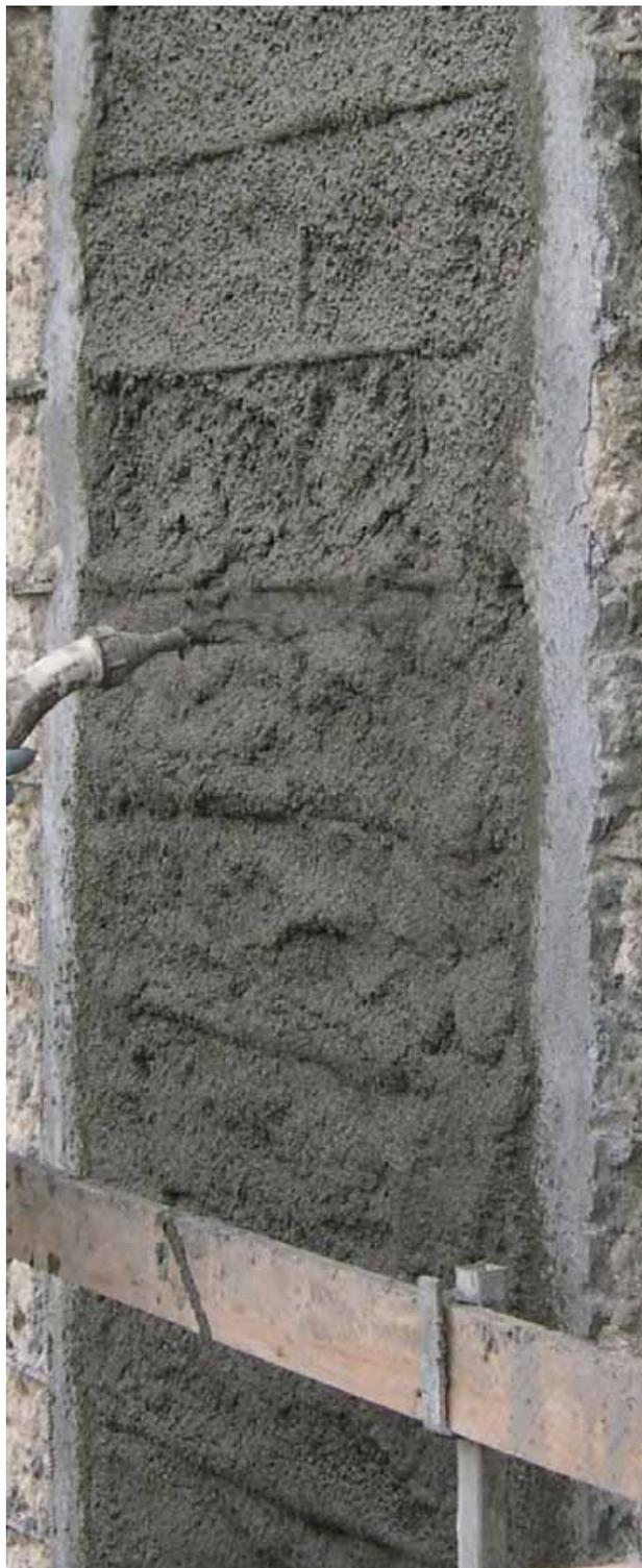
EMACO NanoCrete R4 può essere messo in opera, per spessori da 5 mm a 50 mm, a cazzuola (piccole superfici) o mediante macchine spruzzatrici (superfici estese) a coclea o a pistone (non a ciclo continuo).
