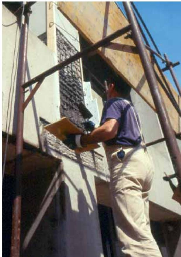
EMACO NanoCrete R4 è applicabile sia a cazzuola che a spruzzo anche su superfici solamente sabbiate. Consente interventi di spessore da 5 mm a 50 mm senza la necessità di essere armato con rete elettrosaldata. Per interventi di spessore superiori a 50 mm è possibile l'applicazione in più strati, attendendo circa 24 ore tra uno strato e l'altro. I suoi campi di applicazione specifici sono rappresentati dal ripristino di:
