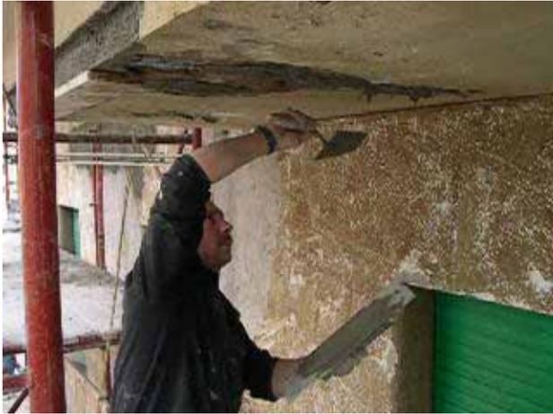
Negli interventi ove previsto l'utilizzo del passivante, EMACO NanoCrete R4 va applicato quando la seconda mano di EMACO NanoCrete AP ha raggiunto la condizione di fuori tatto. Durante le fasi di interruzione dello spruzzo (funzione anche della temperatura esterna) è necessario prevedere l'accurata pulizia delle tubazioni e della pompa stessa mediante acqua in pressione e palla di gomma morbida pulisci tubi.
