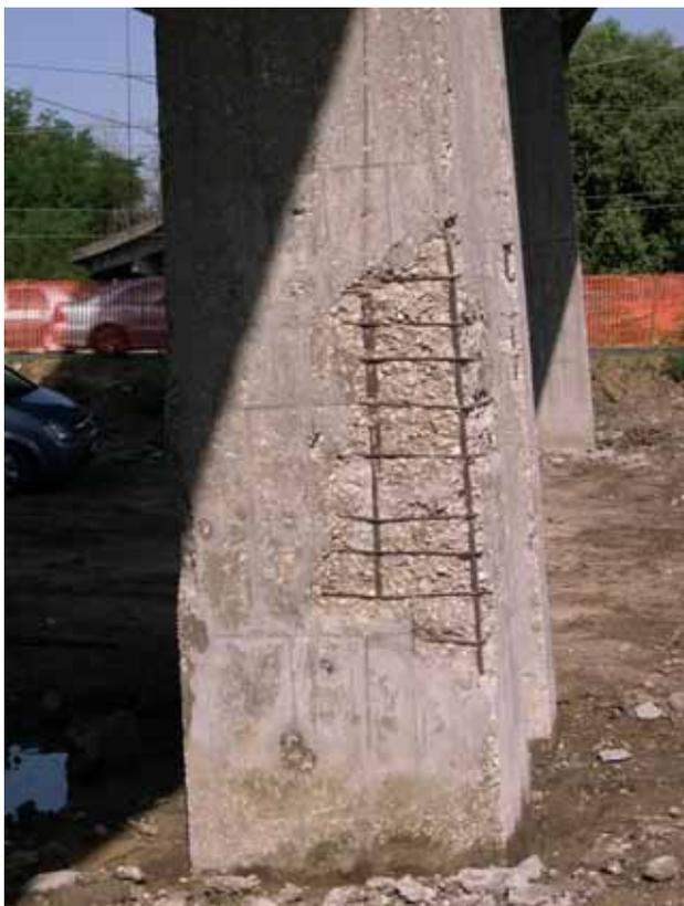
E' particolarmente indicato nel caso di degradi localizzati e/o per interventi su elementi strutturali di difficile accesso per i quali una perfetta preparazione del calcestruzzo di supporto è praticamente impossibile.
