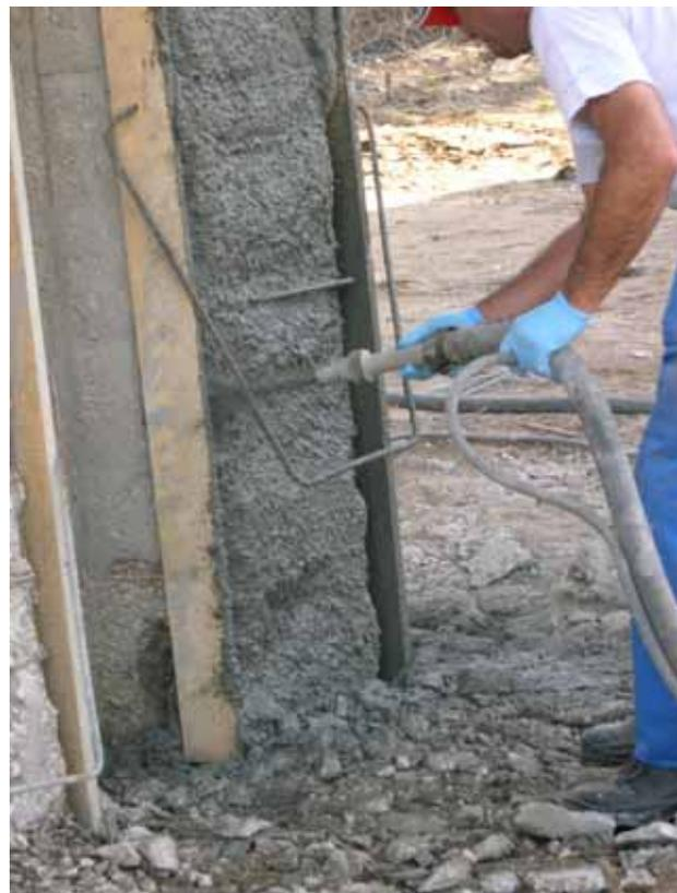
Durante le fasi di interruzione dello spruzzo (funzione anche della temperatura esterna) è necessario prevedere l'accurata pulizia delle tubazioni e della pompa stessa mediante acqua in pressione e palla di gomma morbida pulisci tubi.
